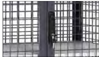
Treibriegelverschluss mit Schwenkhebel und Zylinderschloss.
