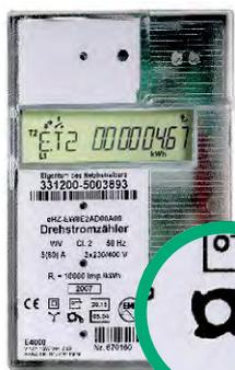
**Zähler mit Rücklaufsperrung. Verhindert unerlaubtes Einspeisen.**
