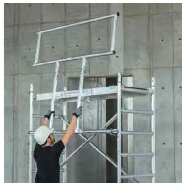
Vor dem Besteigen der ersten Plattform wird der Zusatzrahmen mühelos vom Boden aus eingesteckt.
