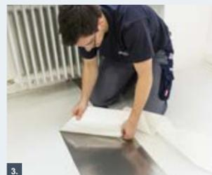
Mit einem weichem Bleistift Referenzlinie auf dem Schutzpapier herstellen. Dient als Startpunkt für die erste Belagsreihe. Schiene an der Referenzlinie anlegen und Schutzpapier entlang der Schiene abziehen.
