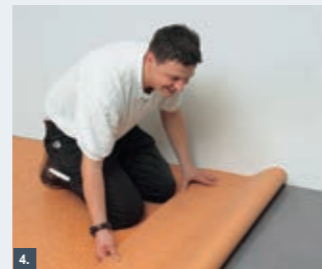
4. Neuen Bodenbelag spannungs- und wellenfrei einlegen und gut anreiben – sofort begeh- und belastbar!
