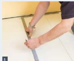
Mit einem weichem Bleistift Referenzlinie auf dem Schutzpapier herstellen. Dient als Startpunkt für die erste Belagsreihe. Schiene an der Referenzlinie anlegen und Schutzpapier abziehen.
