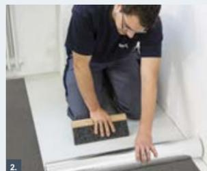
Sigan Elements Plus in Laufrichtung des neuen Bodenbelages auf den Untergrund kleben.
