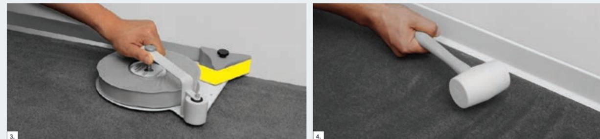
3. Toptac 35 mit Auftragsgerät an Wand anbringen. Für TS 100 und S 100 von Hand einen zweiten Streifen Toptac 35 direkt oberhalb des ersten Streifens ansetzen.
