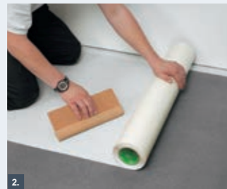
2. Sigan 1 in Laufrichtung des neuen Bodenbelages auf den Untergrund kleben.
