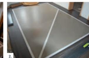
Einteilung der diagonalen Verlegerichtung mittels Sigan Elements Universal Tape. Die so hergestellte Linie dient als Orientierungslinie für die Diagonalverlegung innerhalb der Spiegelfläche. Das Sigan Elements bzw. Sigan Elements Plus wird an das Sigan Elements Universal Tape angelegt und zugeschnitten.
