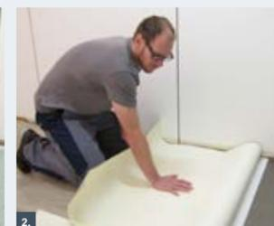
2. Neuen Bodenbelag spannungs- und wellenfrei einlegen.
